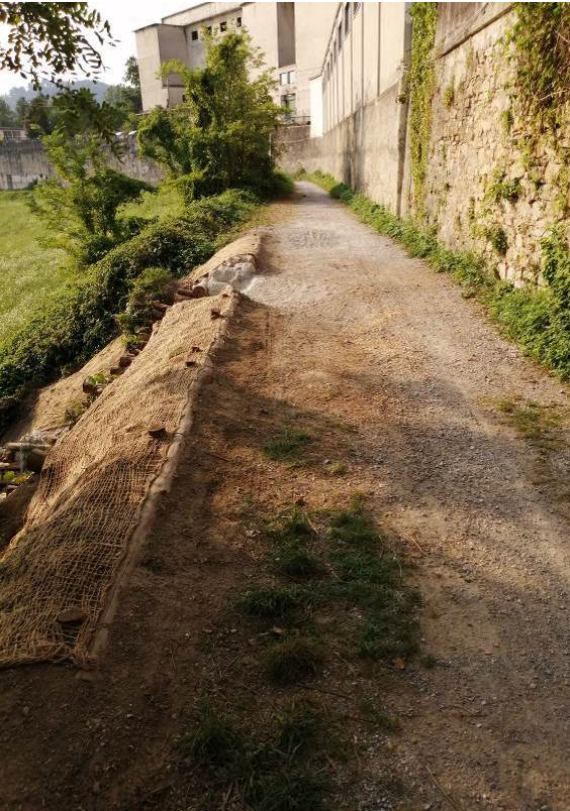
Foto sotto ex Cementeria
