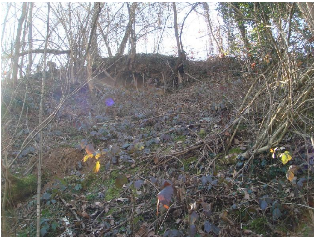
Figura 13.8 - Frana presso Cascina Brughiera – corpo di frana
