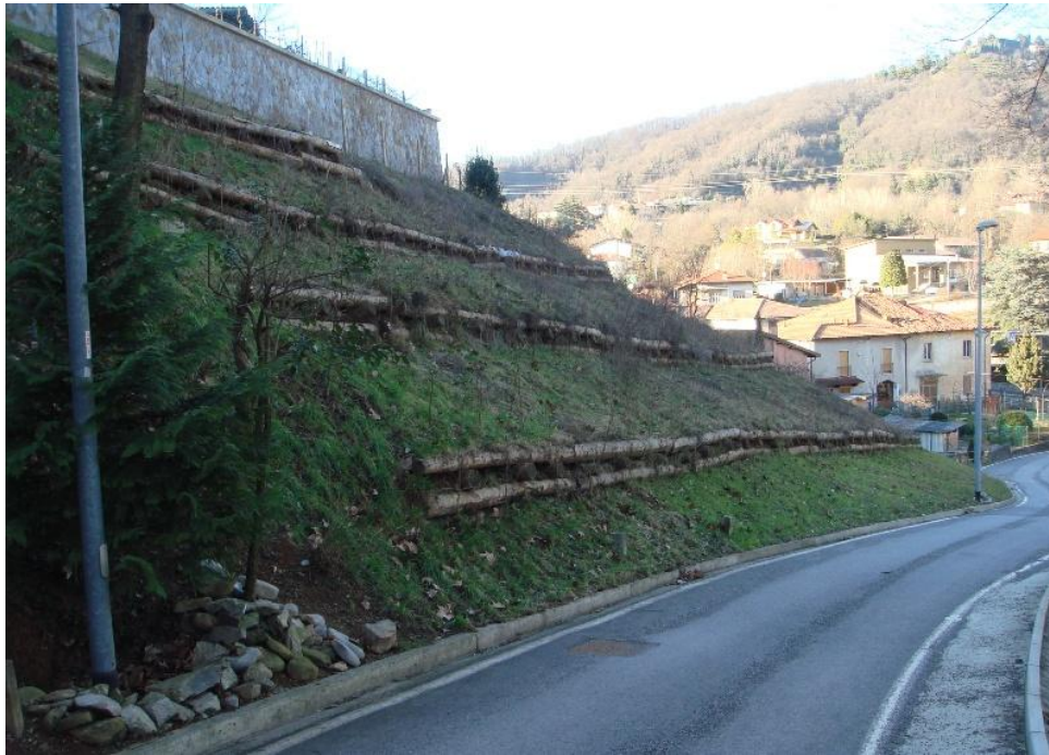
Figura 13.11 - Frana di Cascina Butto – messa in sicurezza/stabilizzazione con interventi di ingegneria naturalistica
