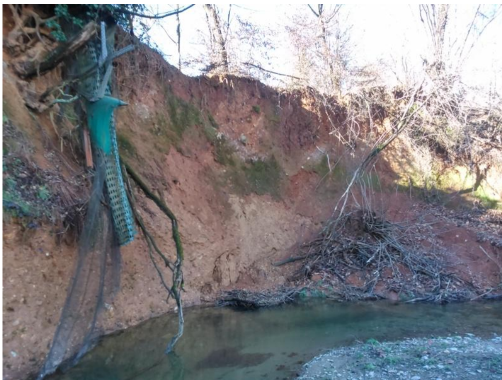
Figura 13.3 - T. Lavandaia - erosione spondale con arretramento/franamento del ciglio su meandro esterno
