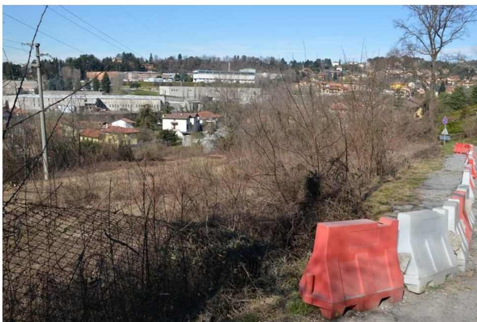
Figura 13.10 - Frana di via Monsignor Beretta in località Molinata – area di frana a valle della sede stradale
