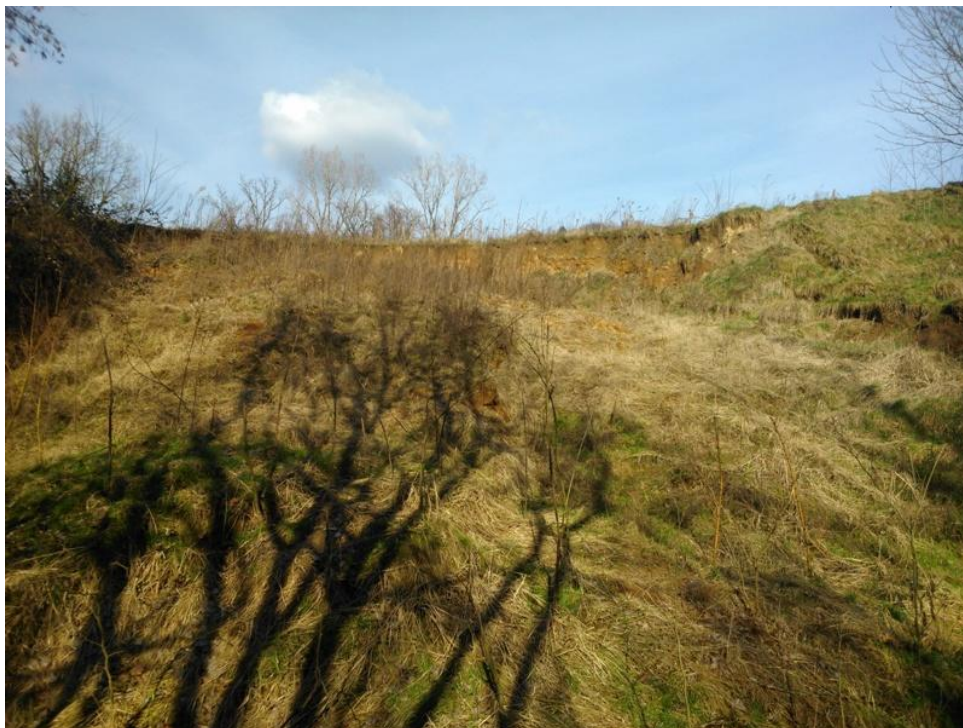
Fig. 13.9 - Frana presso Cascina Pila – corpo di frana e coronamento
