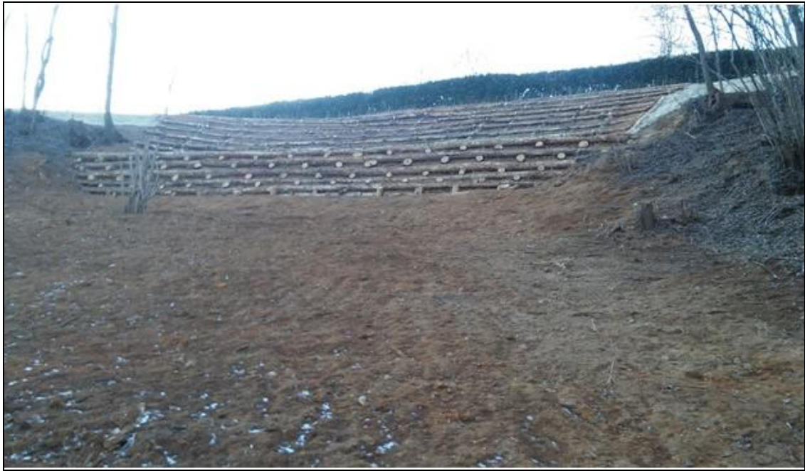
Figura 13.12 - Frana di Cascina Brughiera – interventi di consolidamento del coronamento con tecnologie di ingegneria naturalistica e riprofilatura del corpo frana
