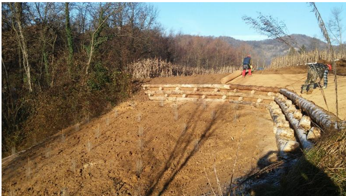
Figura 13.15 - Frana di Cascina Pila – riprofilatura e stabilizzazione del coronamento e del corpo frana con interventi di ingegneria naturalistica e piantumazione
