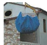
2. E' tassativamente vietato sollevare i fasci di barre dei ferri, pacchi di reti elettrosaldate, gabbie di armatura, legname vario in modo sfuso o utilizzando i legacci così come sono stati consegnati dai fornitori. Il gruista deve sempre sollevare il materiale sciolto mediante regolare incravattature o tiranti a cappio che serrino efficacemente il materiale sciolto.
