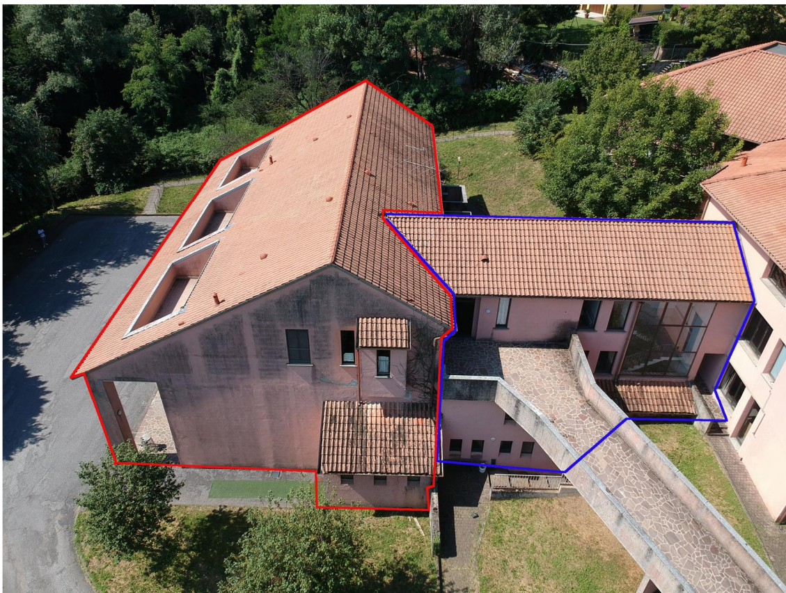
Figura 1 - Edificio PALESTRA ed edificio SPOGLIATOI
